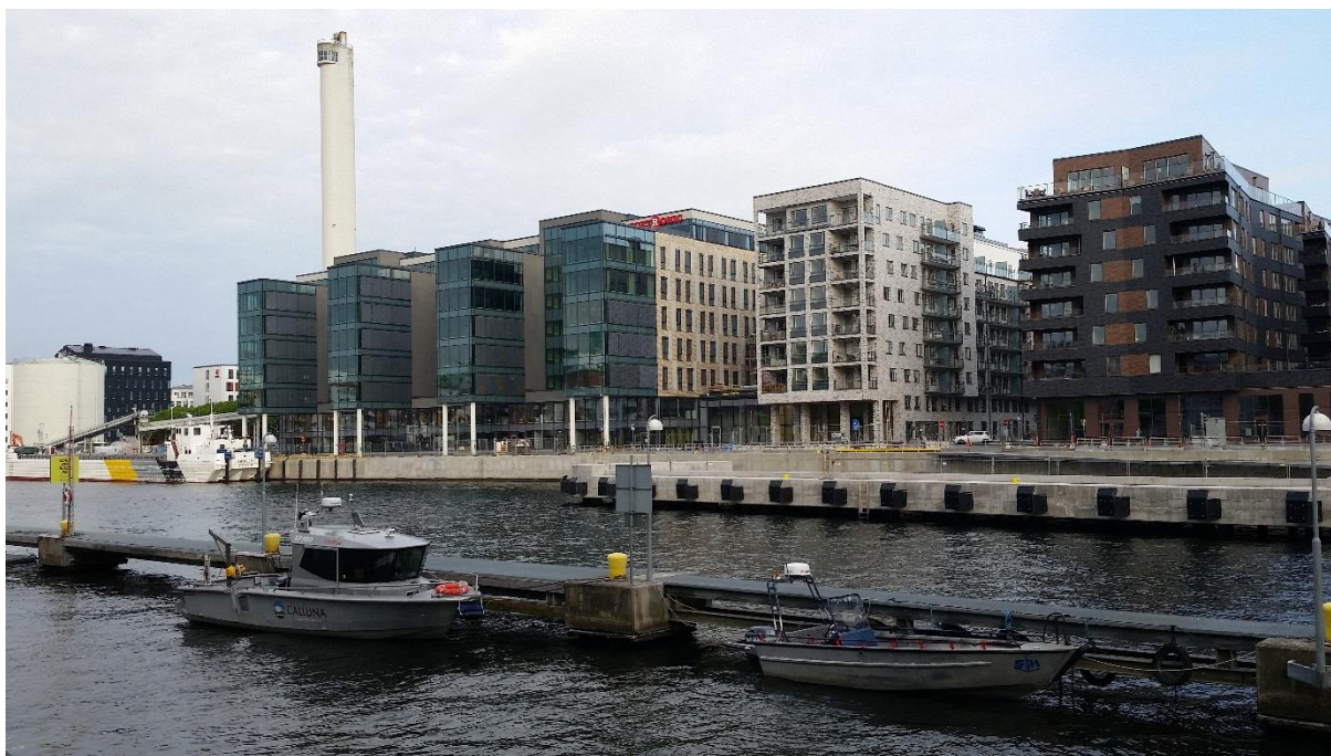
Hammarbyhamnen och Mårtensdal, med Hammarbyverkets skorsten i bakgrunden. Foto: Joakim Lücke.
