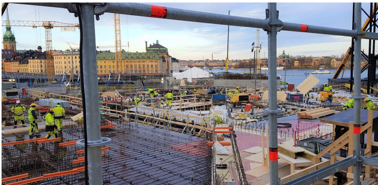
Ombyggnaden av Slussen pågår för fullt i februari 2020. Foto: Joakim Lücke.
