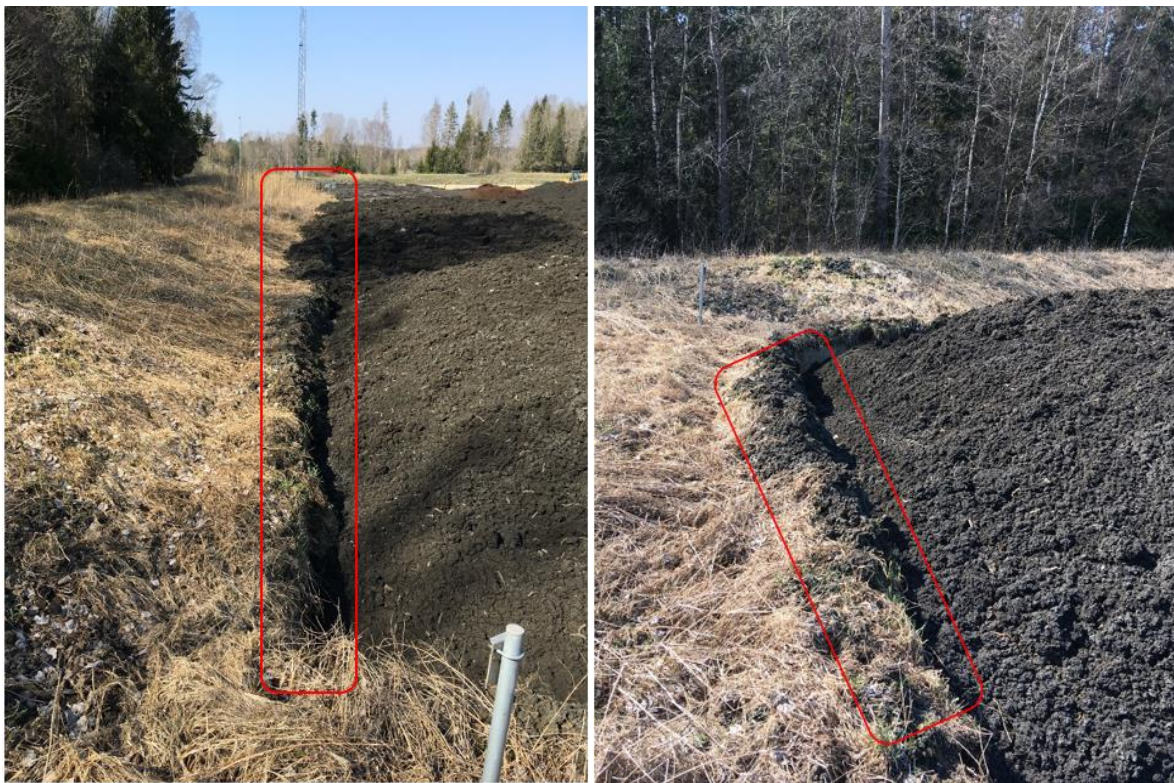
Figur 1 Brommaslam ligger upp på stödmur och vall
