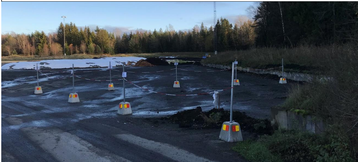
Figur 3 Avspärning vid infart till plattan för att styra lagring av slammet bort från avskiljaren.
