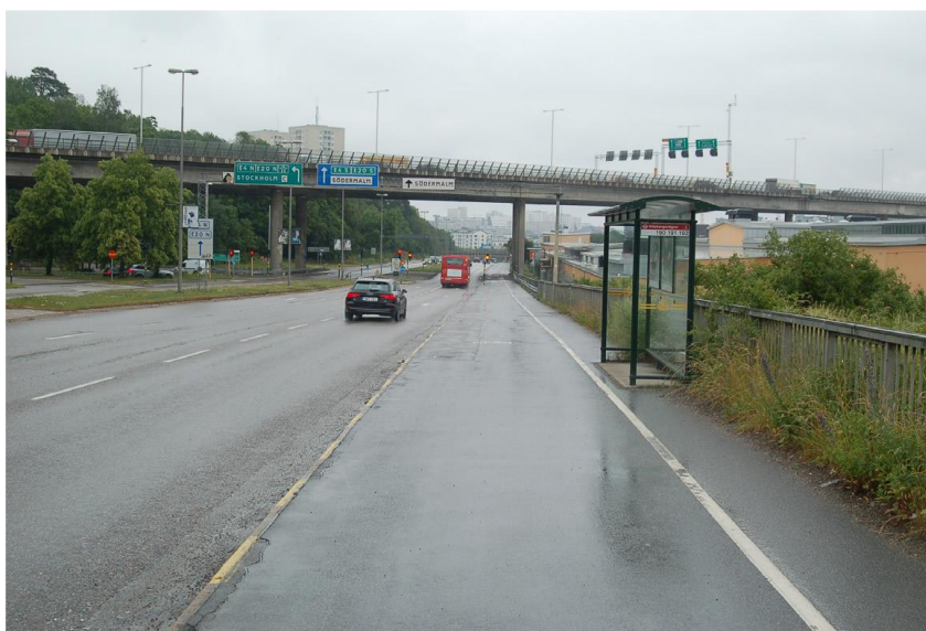
Figur 6. Gångbanan blockeras av ett väderskydd
