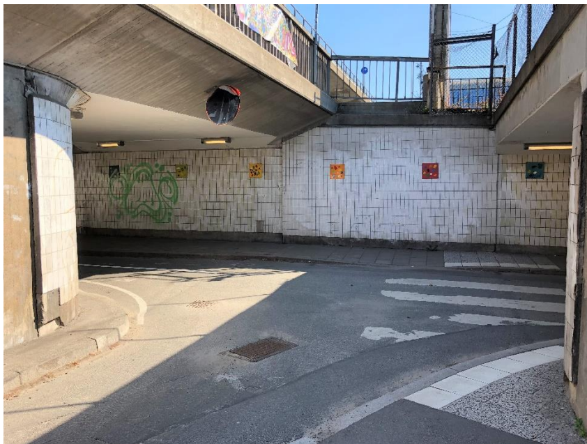
Bild 3) Västra rampen ned mot mitten av tunneln. Skynd sikt och flera kantstenar som ej syns.
