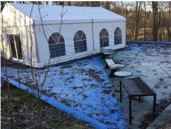
Olovligt uppfört tält på husgrund/fundament som också målats blått. Nedanför Hägerstalunds värdshus.
