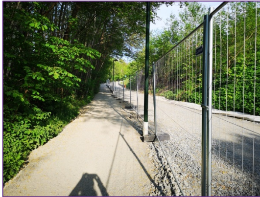
Tillfällig gång- och cykelväg under arbeten med fjärrvärmeledning
