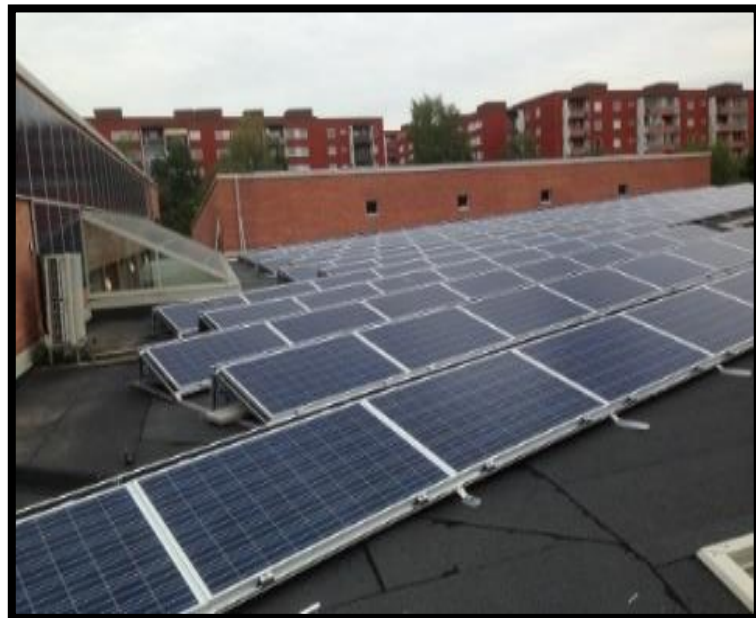
Bild 1: Husbybadet, en av Stockholms stads idrottsanläggningar med solcellspaneler uppförd år 2014 med en elproduktion på 95 MWh per år.
