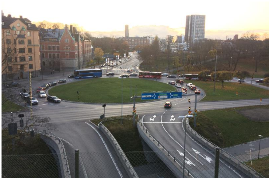
Bild 5, Trafikplats Roslagstull oktober 2019
