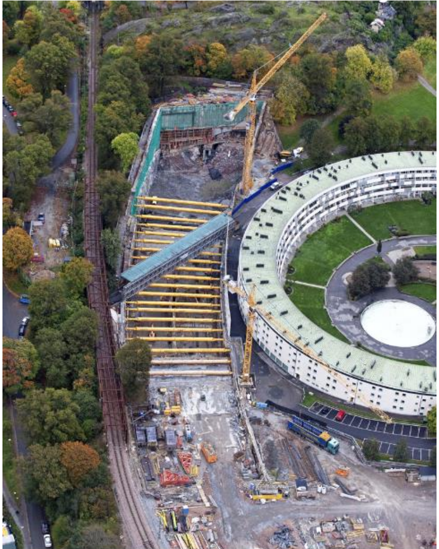
Bild 3, Byggnation av tunneln genom Bellevueparken.
