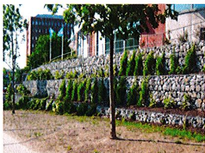
Exempel på gabionmur. Bild: Åsa Wilke.
