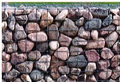
Exempel på gabionmur med större Sten och glesare nät Bild: gds.se
