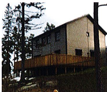
Exempel altan uppbyggd på plintar som förhåller sig till befintlig terräng. Bild: Sundell Arkitekter AB.
