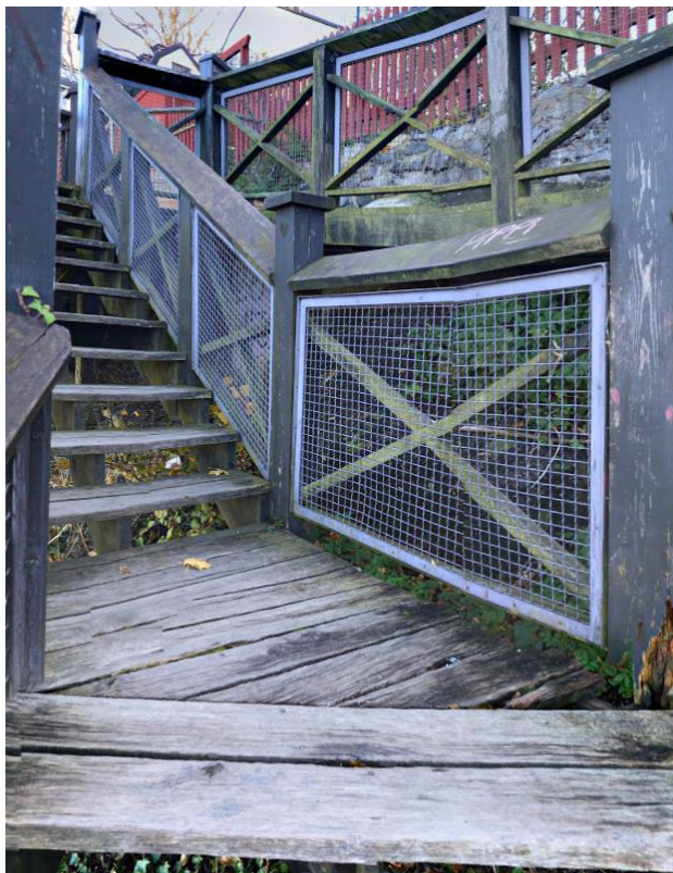
Bild 9- Monteliustrappan före renovering
