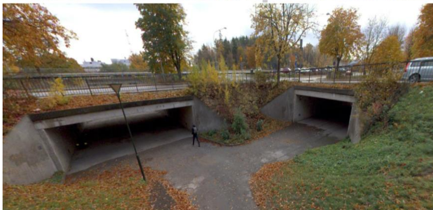
Bild 4- Broarna i korsningen Eksättravägen-Kungssättravägen
