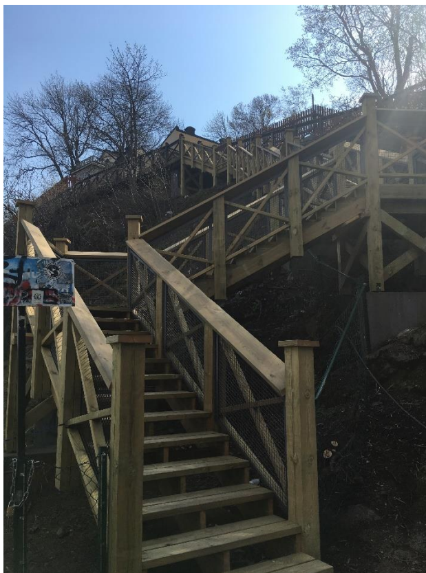
Bild 10- Trappan i färdigrenoverat skick
