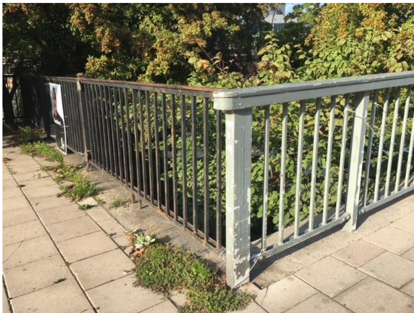
Bild 6- Detaljbild på räcket innan ommålning
