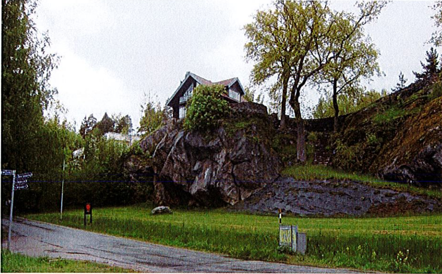
Bergsformationen i sydväst mot Långsjövägen med flera värdefulla ekar. En naturstenstrappa tar sig ner mellan ekarna. En gångstig/ny trappa skulle kunna snedda ner längs den lägre slänten som på bilden syns plastövertäckt mot ogräs.
