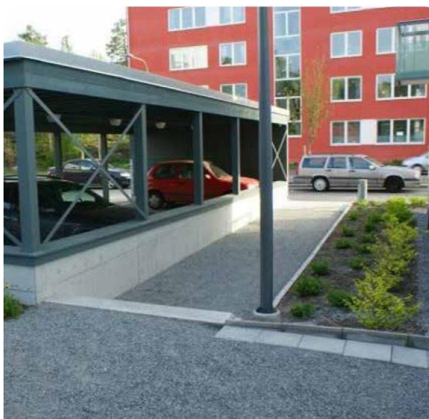
Figur 5-5. Exempel på genomsläpplig beläggning i form av grus.
