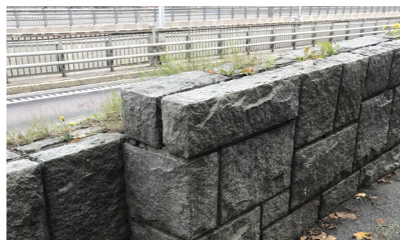
Exempel rubbelmur vid den nya parkeringsplatsen som knyter an till befintlig gestaltning.
