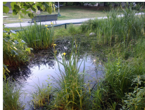
Referensbild på dike med växter som tål både torka och vatten, och samtidigt fungerar som fördröjning och rening för dagvattnet.
