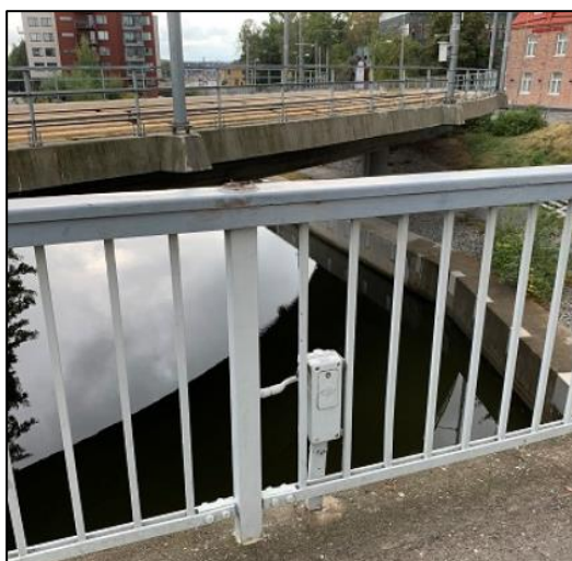
Figur 7, avsågad belysningsstolpe. Sladdar sticker upp i räcket.
