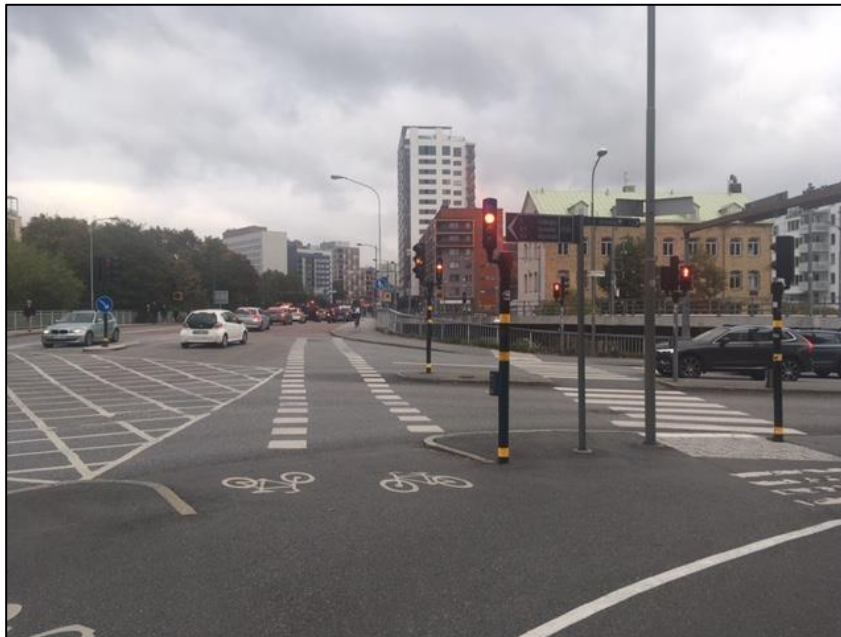
Figur 11, befintlig cykelpassage anläggs i röd asfalt.
