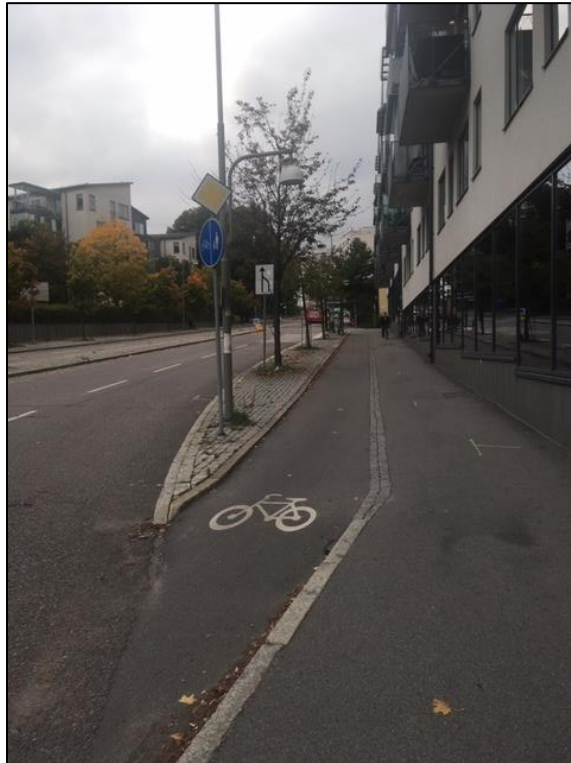
Figur 10, befintlig cykelbana på norra sidan om Bällstavägen.
