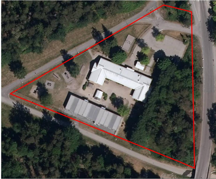
Figur 1. Befintliga byggnader inom området Förskolan Kardemumma, Tyresö Kommun. Det geotekniska undersökningsområdet är beläget inom röd markering.
