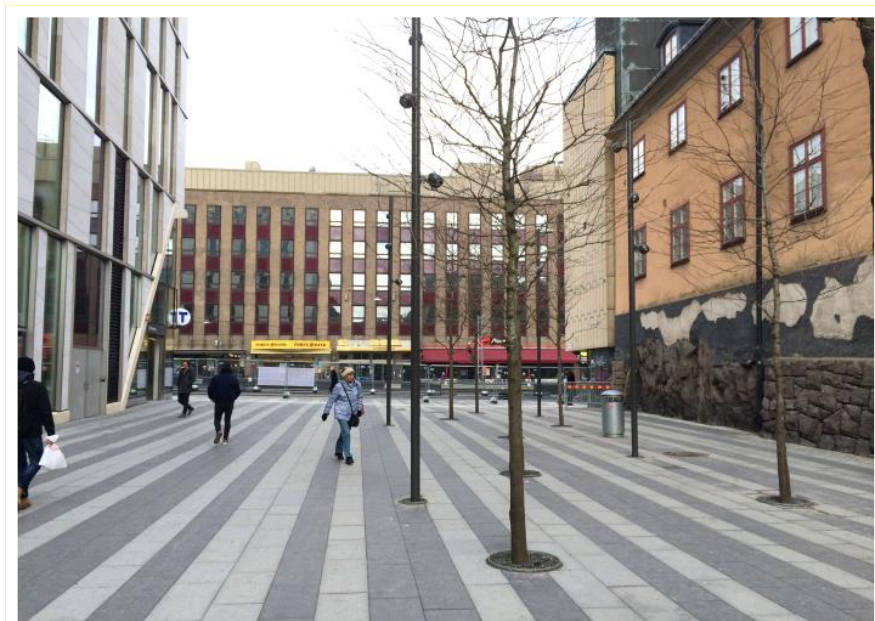
Figur 9. Klara västra kyrkogata efter ombyggnation.
