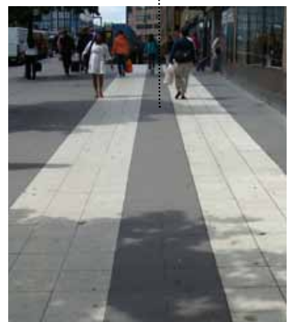
Marken återställs med betongplattor i storlek 70x35 cm.
