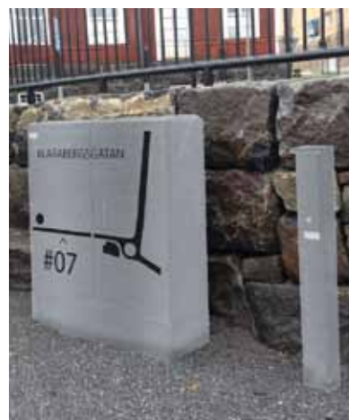
Teknik- och elskåp får ett enhetligt utseende och placeras mot fasader och murar.
