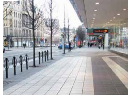
Befintlig markbeläggning på Hamngatan. Ytan återställs med betongplattor i storlek 70x35 cm.
