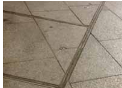
Vissa brunnslock kan fyllas med samma beläggning som intilliggande mark.
