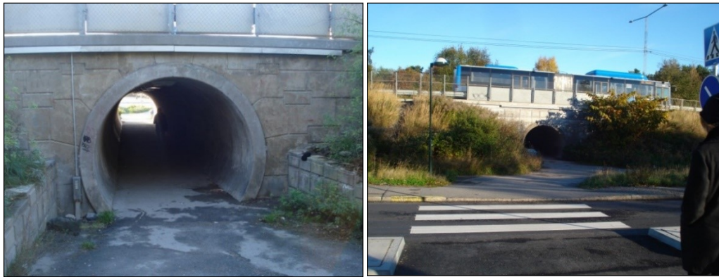
Figur 8 Gångtunneln mellan hållplatserna.
