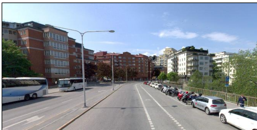
Figur 8, Aktuell sträcka längs Klarabergsgatan/Klarabergsviadukten.
