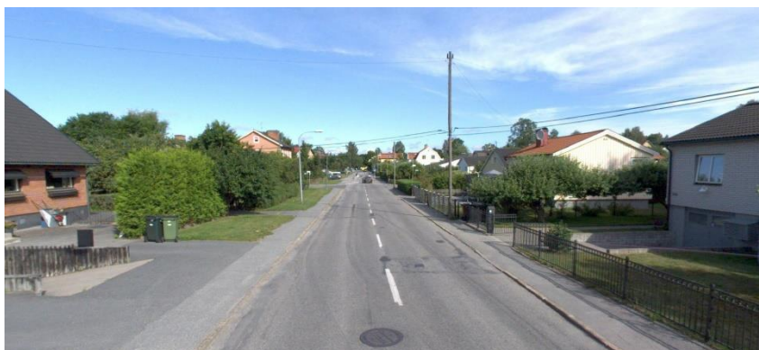
Figur 55 Årdalavägen mellan Aspövägen och Helgestavägen.
