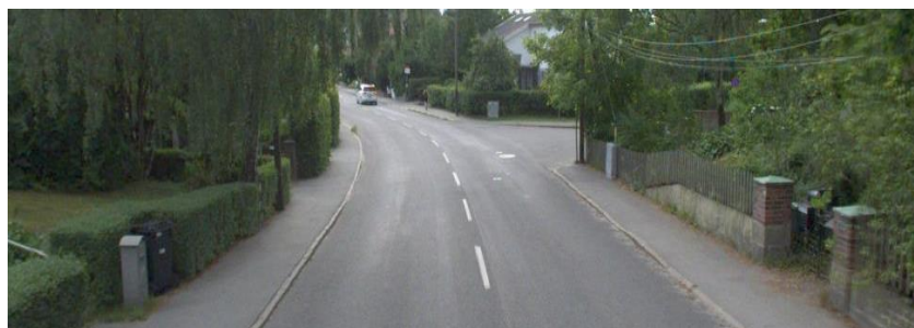
Figur 31 Långsjövägen mellan Långbrodalsvägen och Svartlösavägen.
