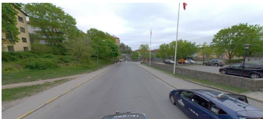
Figur 22 Vidängsvägen mellan Tranebergsvägen och Gustavslundsvägen.
