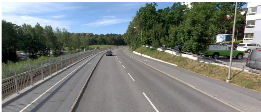
Figur 45 Rågsvedsvägen mellan Önskehemsgatan och Mellanvägsbacken.
