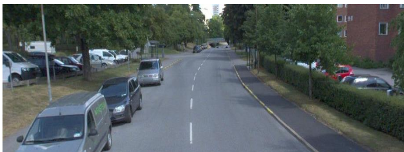
Figur 37 Glanshammarsgatan väster om Huddingevägen.
