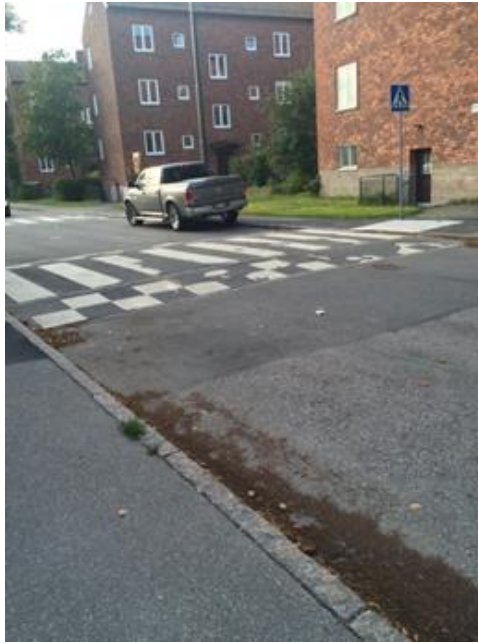
Bild 2: Upphöjt övergångsställe (platågupp)
