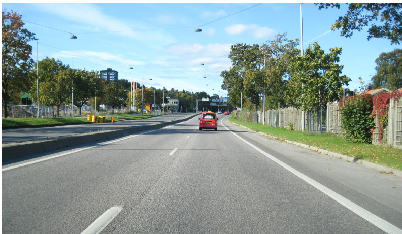
Bergslagsvägen vid Bällstavägen, riktning västerut.
