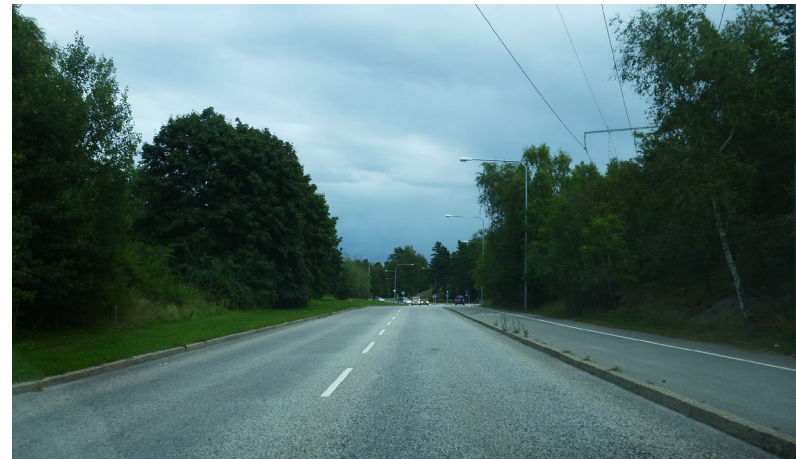
Kontrollvägen vid Diamantbacken, riktning norrut.
