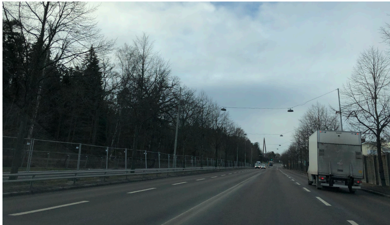
Drottningholmsvägen vid Gubbkärrsvägen, riktning sydväst.
