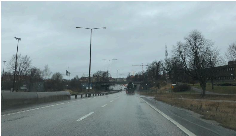
Magelungsvägen vid Mässkopplet, riktning västerut.
