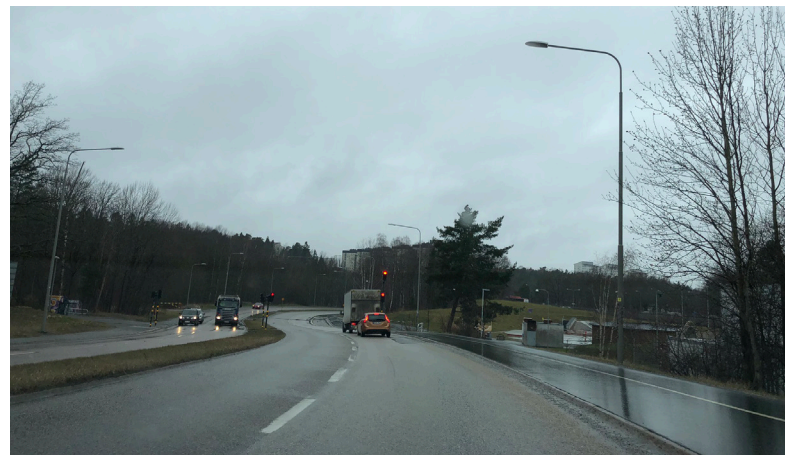
Magelungsvägen vid Högdalens Brädåkningspark, riktning norrut.
