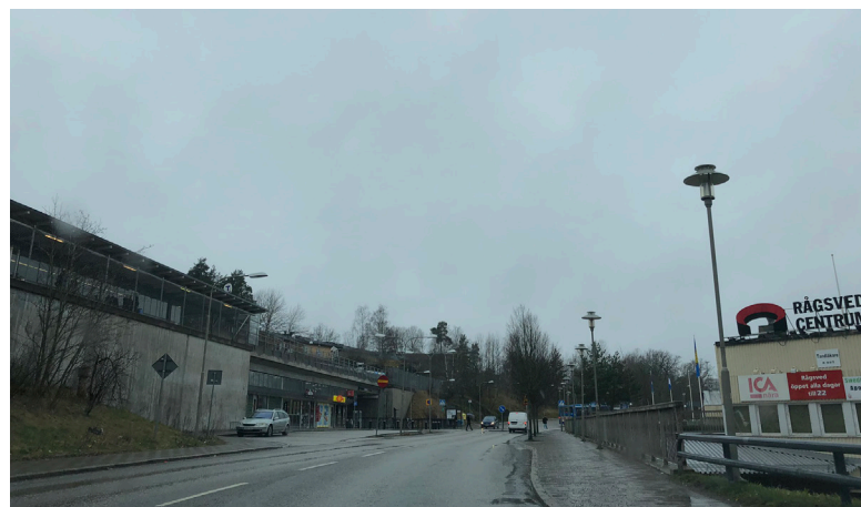
Rågsvedsvägen vid Rågsveds centrum, riktning västerut.
