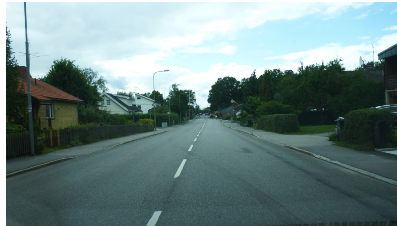
Mickelsbergsvägen vid Solrosvägen, riktning västerut.
