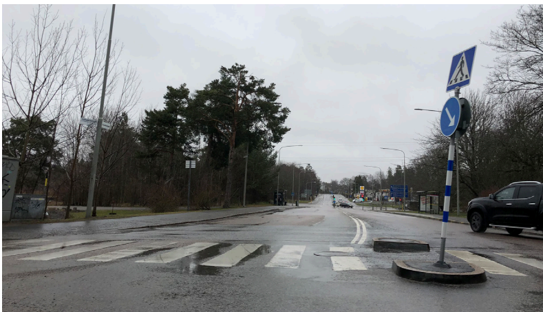
Grycksbovägen vid Trollesundsvägen, riktning norrut.
