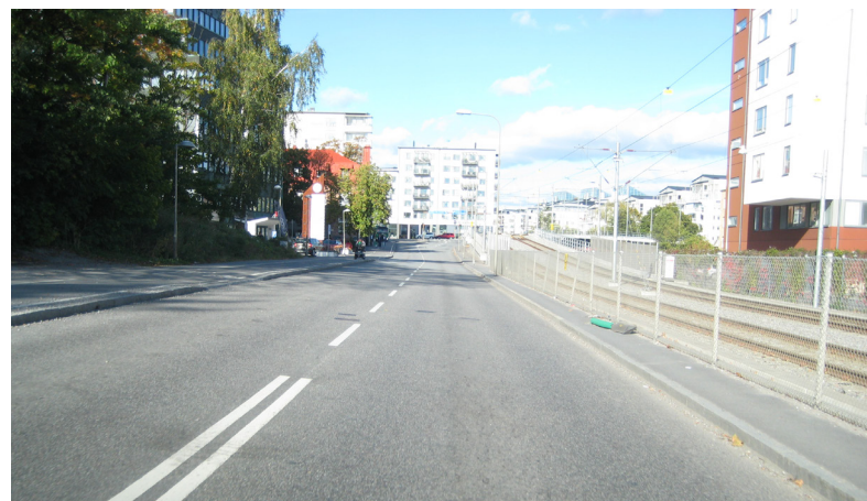
Karlsbodavägen vid Gårdsfogdevägen, riktning norrut.
