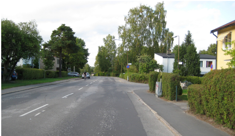
Årdalavägen vid Aspövägen, riktning söderut.
