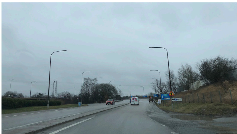
Magelungskopplet vid Huddingevägen, riktning österut.
