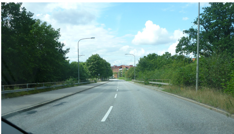
Götalandsvägen vid Toffelbacken, riktning västerut.
