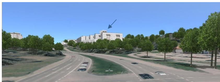
Vy från korsningen Huddingevägen/Rågsvedsvägen i söder, med kvarteret Stubbneken i förgrunden och höghuset i bakgrunden. Bild: Stockholms stad.
