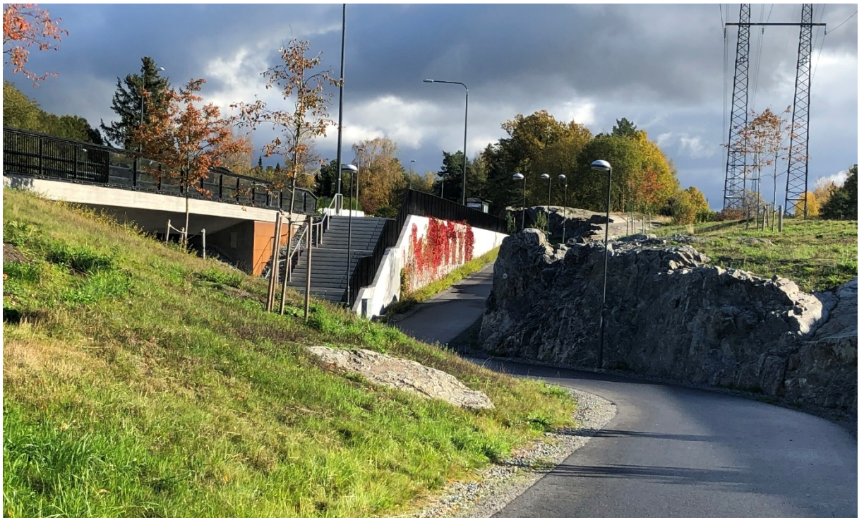
Bild 3. Trappa och ramp till busshållplats i mitten. Till vänster bron över tunneln.
