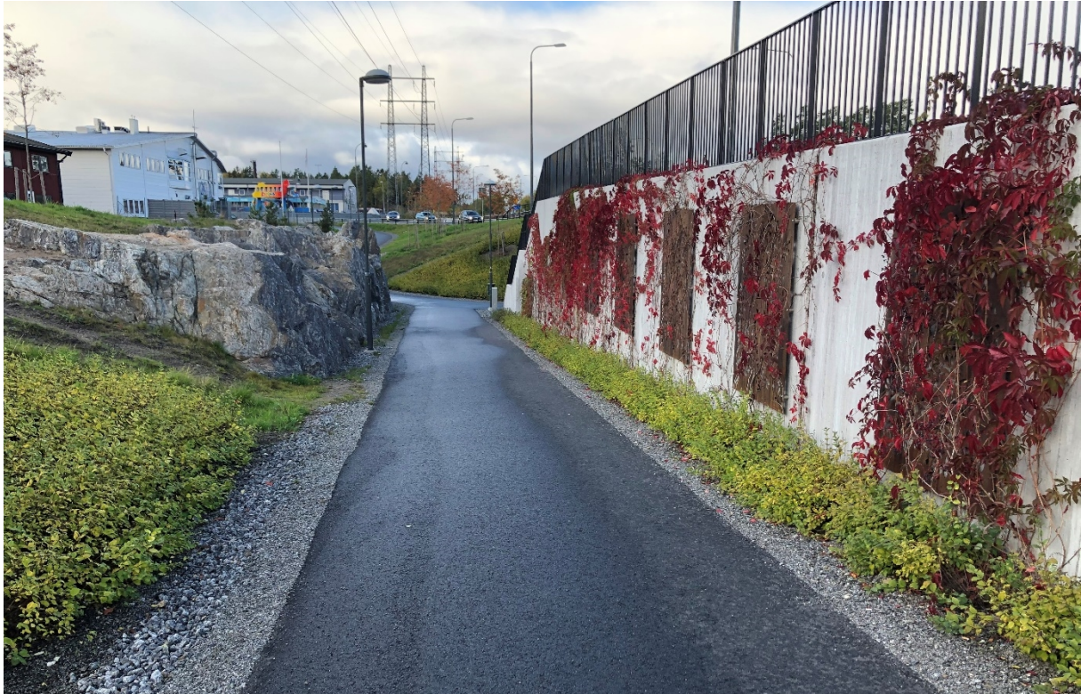
Bild .2 Ramp från busshållplats.
