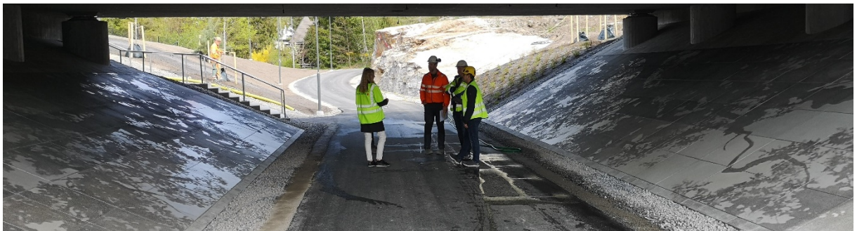
Bild 4. Betongkonst i tunneln.
