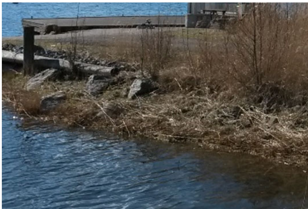
Figur 25: Sten och block i slänter vid kaj samt naturligt erosionsskydd av växtlighet inom Brevik 1:1. Foton 2016-04-11.
