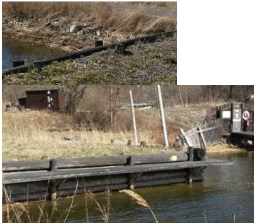
Figur 18: Befintlig stödkonstruktion i trä.
