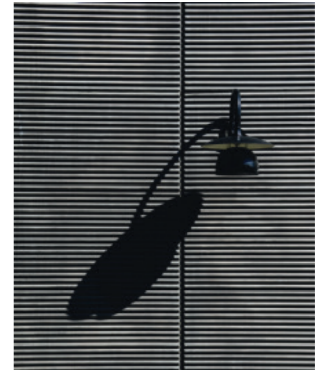
Exempel på matrisgjuten betong
