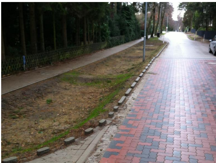
Figur 17. Exempel på ett svackformat öppet gatudike med öppen kantsten. Foto: Dimitry van der Nat, WRS.
