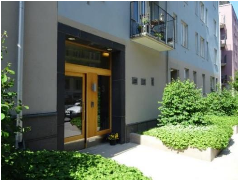
Figur 22. Exempel på regnbäddar för takvatten typ förgårdsmark, Stockholm. Bild: Nacka kommun (2018).
