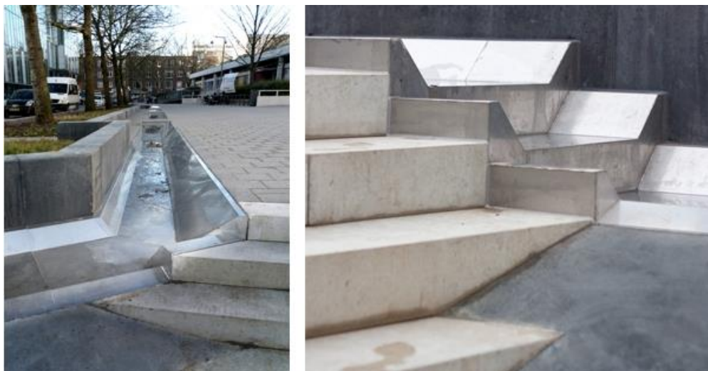
Figur 15. Öppen ränna för dagvattenföring samt kaskadränna för att hantera höjdskillnader på Dagvattentorget Benthemplein i Rotterdam, Nederländerna. (www.urbanisten.nl., 2017)
