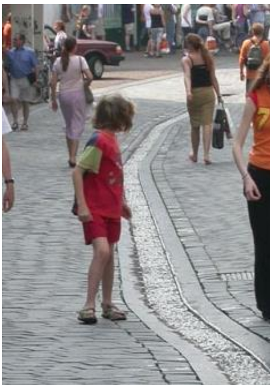
Figur 16. Öppen, stensatt ränna med mycket flacka slänter för dagvattenavledning på en gågata i Nijmegen, Nederländerna. ( www.water-in-zicht.nl , 2017)
