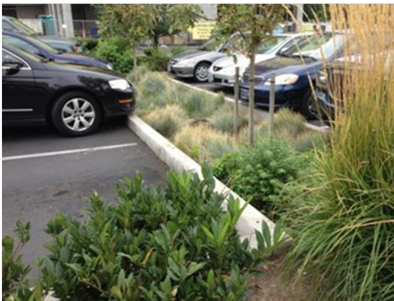
Figur 19. Bildexempel på nedsänkt växtbädd i anslutning till en parkering. Foto: WRS
