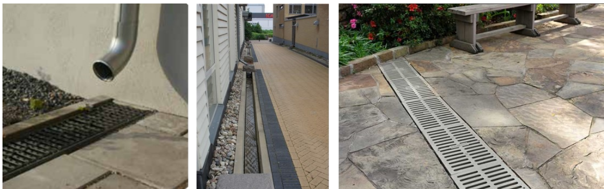
Figur 17. Exempel på takvattenavledning via rännor, bilden till vänster visar rännor med galler och bilden i mitten visar exempel på avledning i öppna rännor och bilden till höger visar en dagvattenränna som leder in dagvatten i en växtbädd. Foto till vänster: Uppsala Vatten, Foto i mitten: WRS, Foto till höger: A1 Guaranteed (2012).
