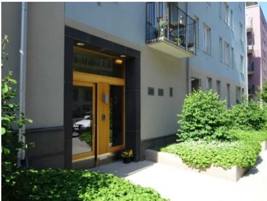
Figur 25. Exempel på regnbäddar för takvatten typ förgårdsmark, Stockholm. Bild: Nacka kommun (2018).
