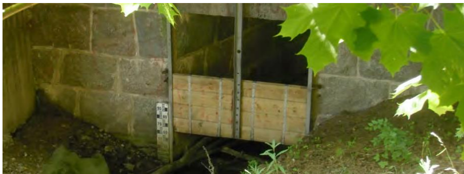
Råcksta träsks utflöde. Dämningsnivån ligger strax under träluckans nederkant. Det är sällan Råcksta träsks vattenyta når så högt. Sker det öppnas sättnarna nedanför Kvarndammen längre ner systemet. Foto: Calluna 2011.
