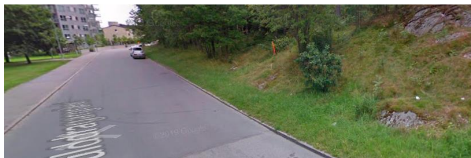
Diket anläggs på högra sidan i släntfoten. Foto: Google maps juni 2020.
