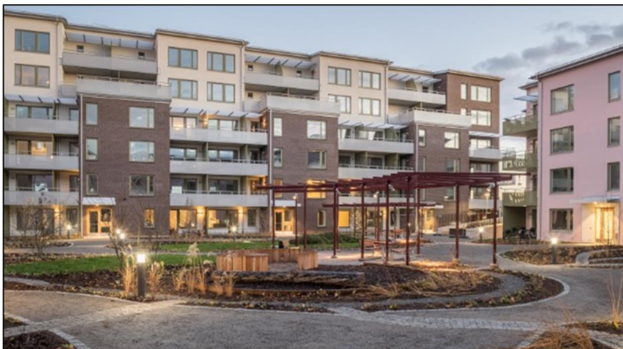
Figur 6-1. Avledning av takvatten till planteringar via rännor anlagda i gatsten. Exempelbild från Linnéhuset i Uppsala (Källa: Uppsalahem).
