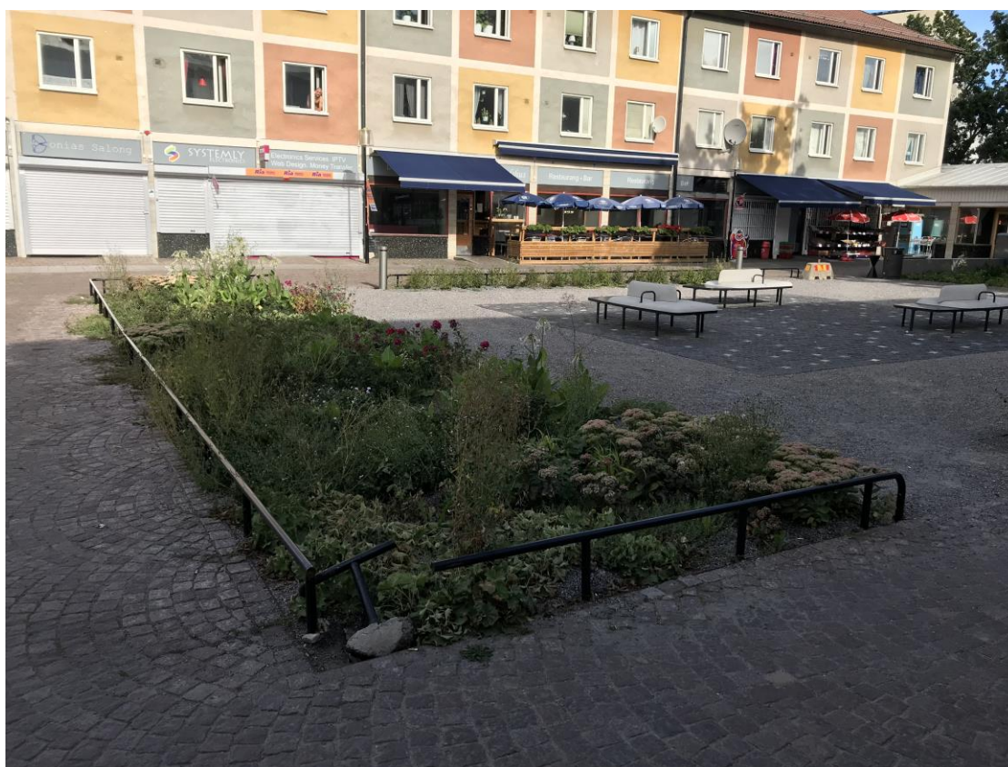
Ormängstorgets centrala del efter upprustningen inom Grönare Stockholm. Underlag för utvärdering av GS satsningen. Här sönderkört räcke och betongsuggor.
