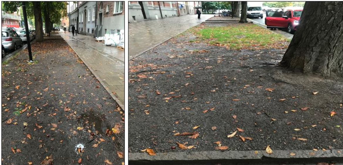
Figur 3. Slitaget på ytorna gör att gräs inte kan växa och att marken blir hård vilket gör att vatten har svårt att infiltrera.
