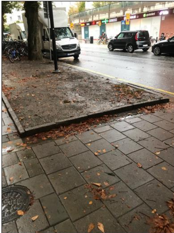
Figur 2. Bilderna visar den slitna, nertrampade ytan runt träden som föreslås ersättas med skelettjord.
