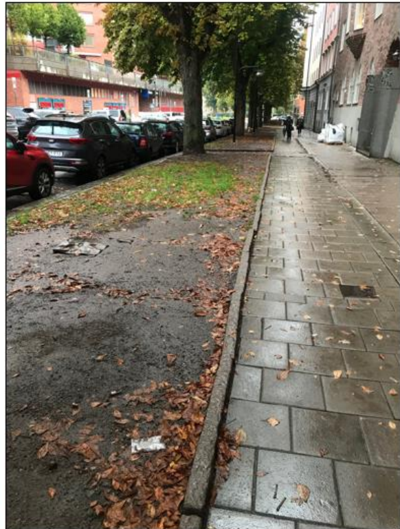
Figur 2. Bilderna visar den slitna, nertrampade ytan runt träden som föreslås ersättas med skelettjord.
