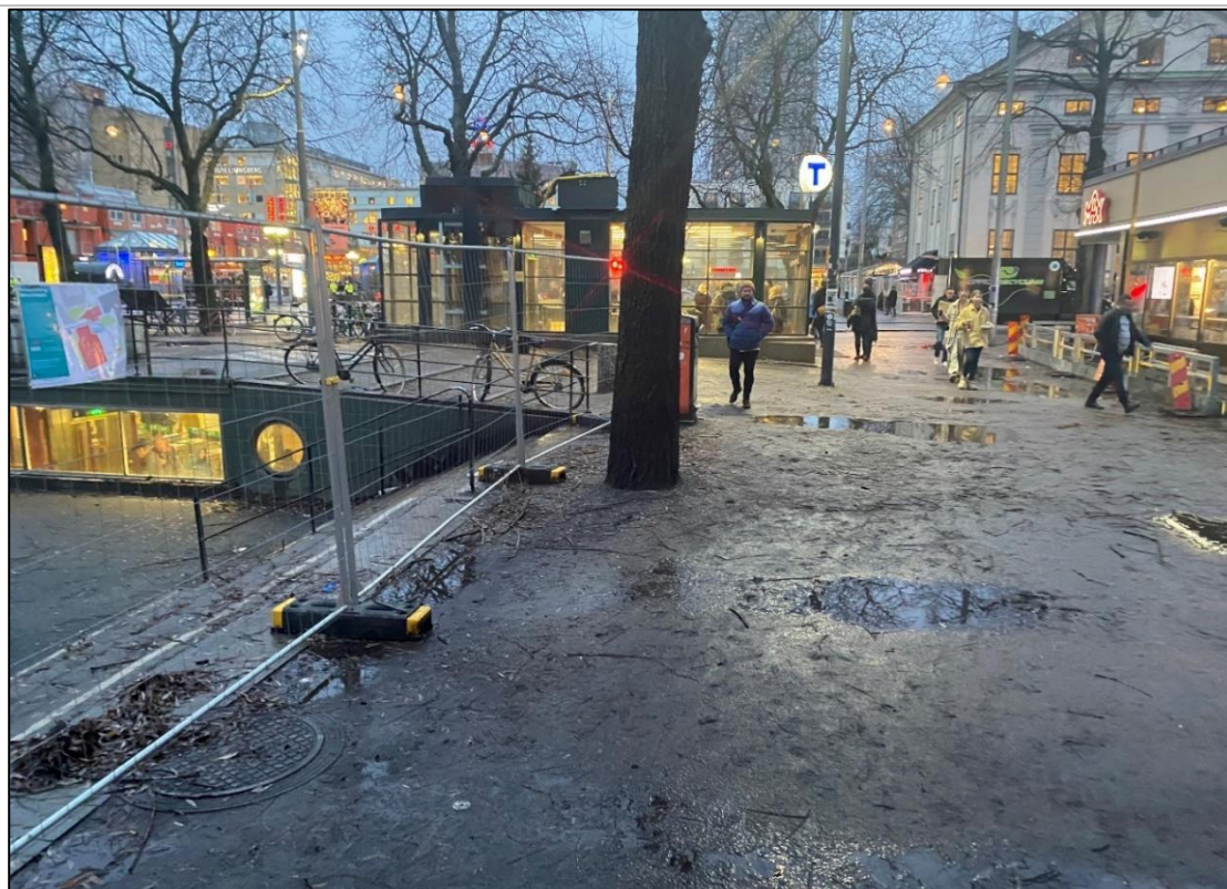
Figur 6. Stenmjölsyta i anslutning till Björns Trädgård. Höjdsättnings- och avvattningsproblem.
