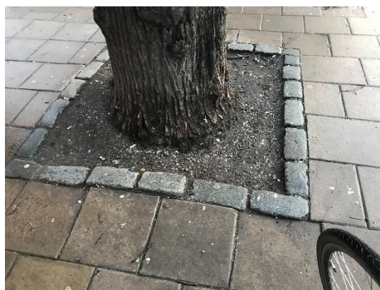
Figur 6. Stenmjölsyta i anslutning till Björns Trädgård. Höjdsättnings- och avvattningsproblem.
