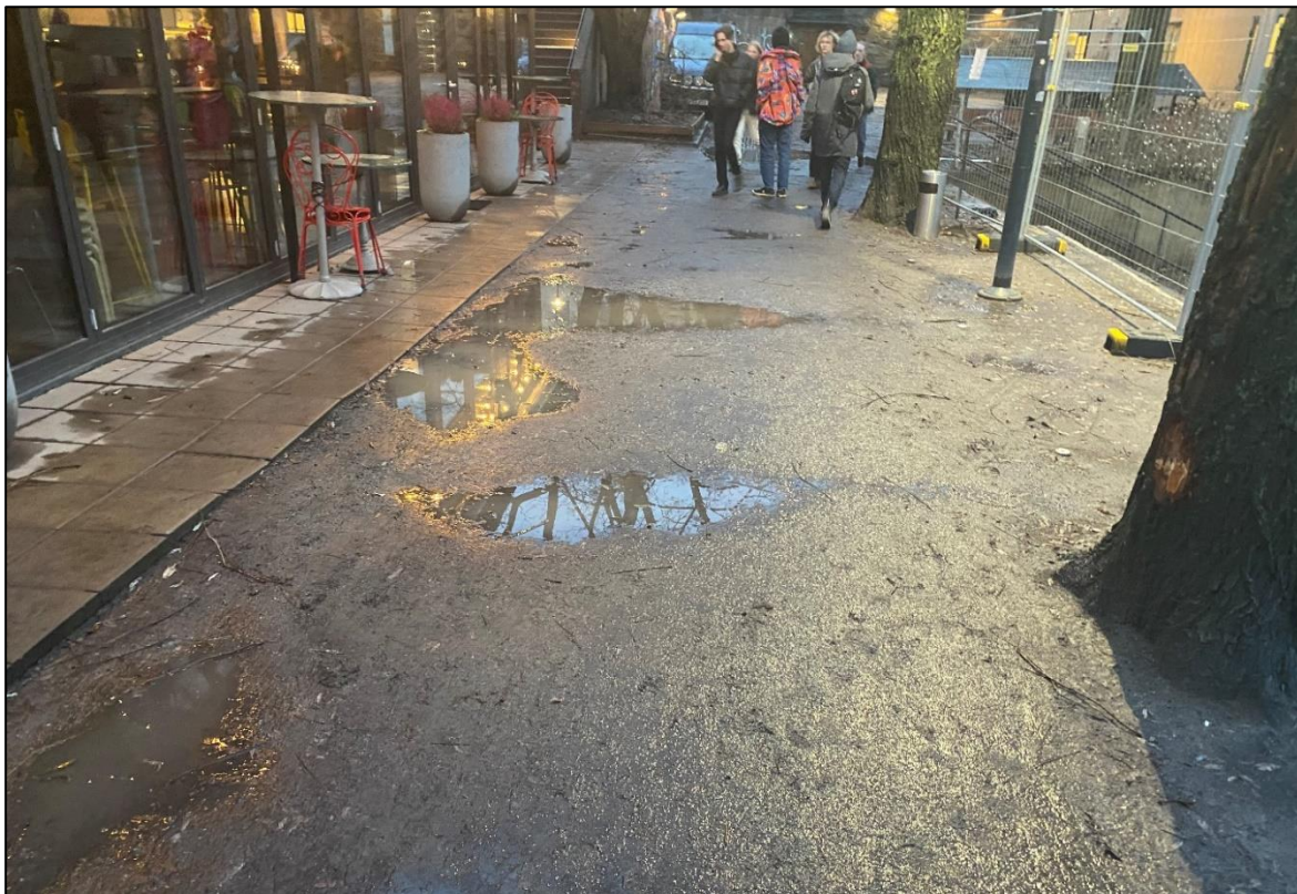
Figur 5. Stenmjölsyta i anslutning till Björns Trädgård. Höjdsättnings- och avvattningsproblem och påkörningsskador på träd.
