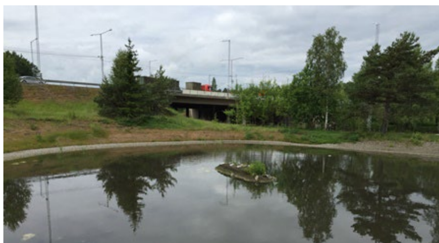
Gudöbrodamarna fördröjer och renar dagvatten från bland annat den hårt trafikerade Gudöbroleden i Haninge. Foto: Hillevi Virgin.
