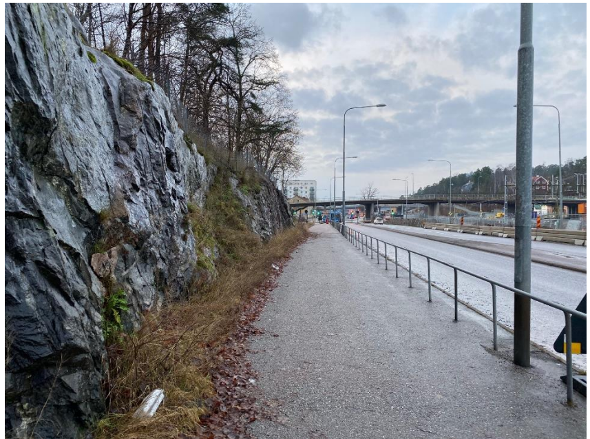
Bild 7 Bromstensvägen söder om Spånga kyrkväg, vy mot norr.
