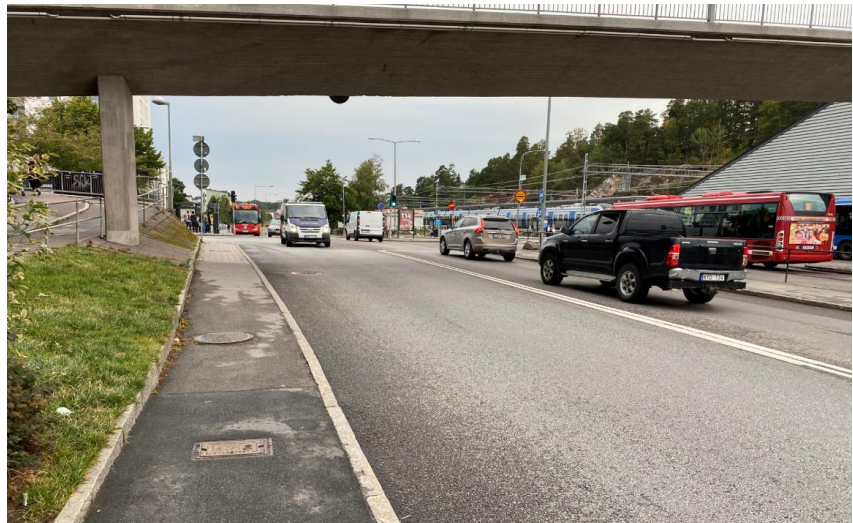
Bild 4 Slänt mot ramp till gc-bro. Vy mot norr.
