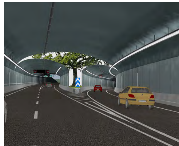
Figur 3.43 Trafikutrymme, förgrening i tunnel.
