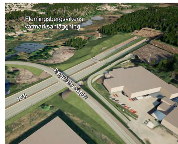
Figur 3.23 Flemingsbergstunnelns västra tunnelmynning sett från väster.
