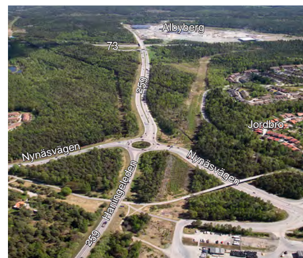
Figur 2.18 Befintlig väg 259 vid Jordbro.
