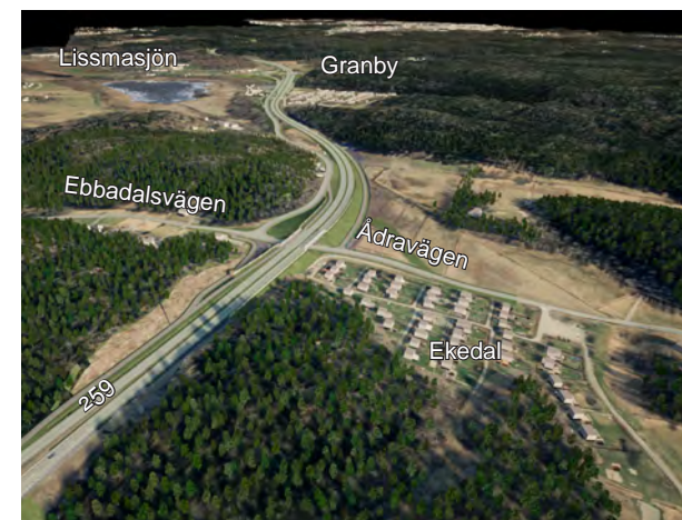
Figur 3.28 Ådravägens passage under väg 259 vid Ekedal sett från väster.
