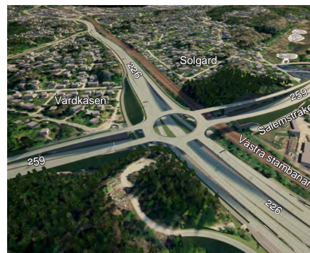
Figur 3.20 Trafikplats Solgård sett från söder.
