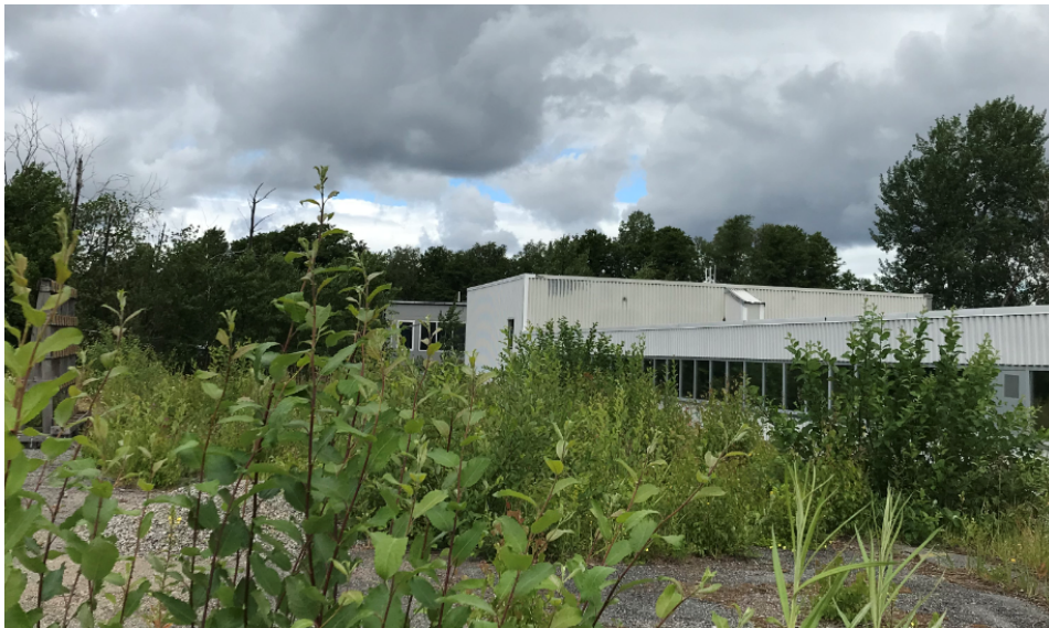
Foto över den sydvästra fasaden av befintlig byggnad.
