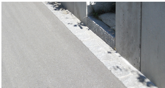
Exempel på bostadsgata inom området: En rad med plattor eller marksten i gräns mellan asfalt och murar, planteringar m.m.
