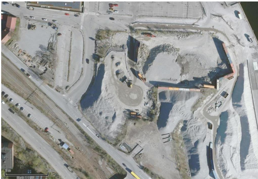
Bild 03. Flygfoto över korsplats med bullerskydd
