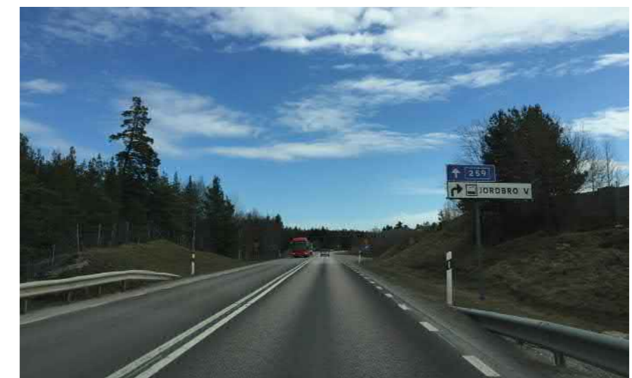
Figur 4.22. Befintlig väg i höjd med Jordbro industriområde.
