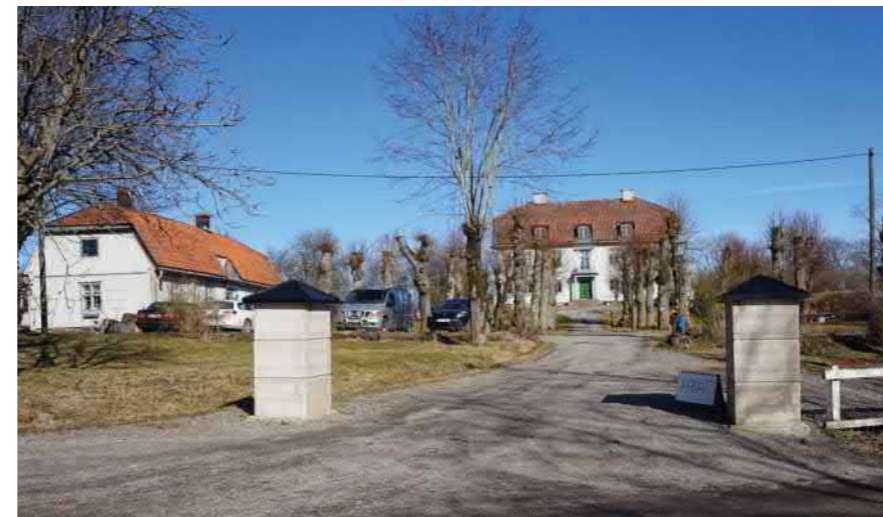
Figur 4.7 Det småbrutna odlingslandskapet är präglad av de många herrgårdarna som ligger samlade kring sjöarna i området. Foto: Tyréns.
