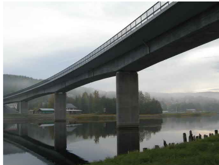
Figur 5.13. Balkbro i betong i flera spann.
