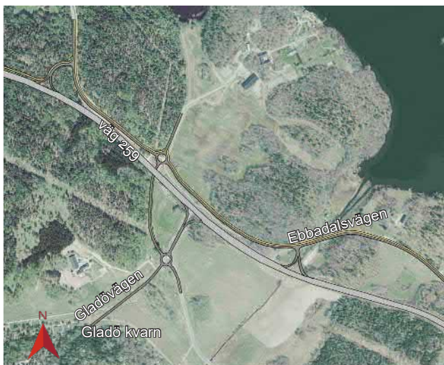
Figur 3.50 Trafikplats Gladö i ett västligt läge, isärdragna klöverramper som kopplar till Ebbadalsvägen och Gladövägen.
