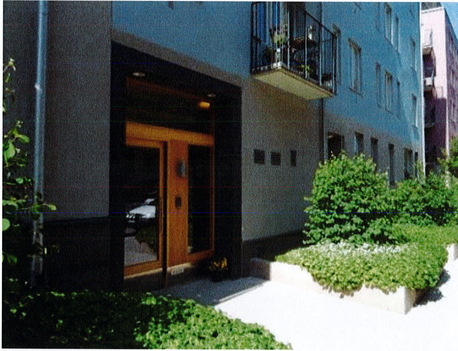
Figur 22. Exempel på regnbäddar för takvatten typ förgårdsmark, Stockholm. Bild: Nacka kommun (2018).
