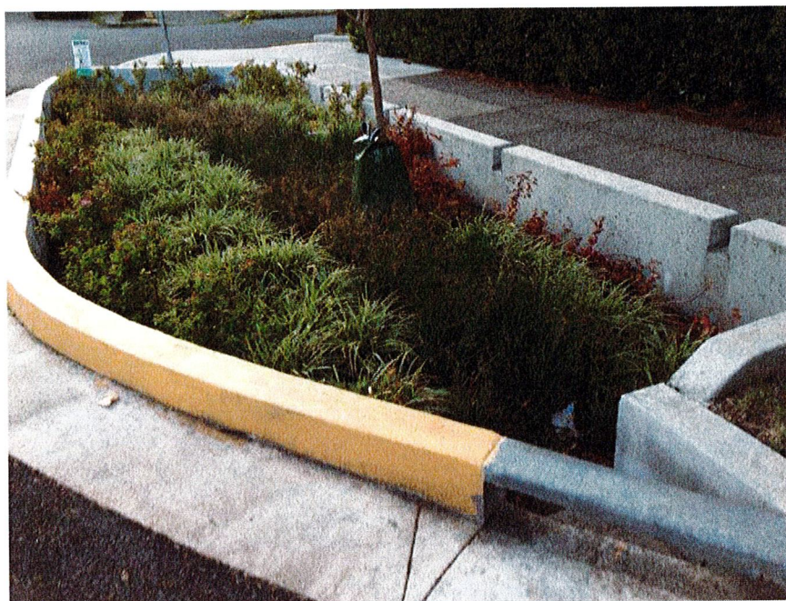
Figur 21. Bildexempel från Portland på nedsänkt växtbädd med träd och andra växter dit dagvatten från väg och trottoar leds. Foto: WRS AB.
