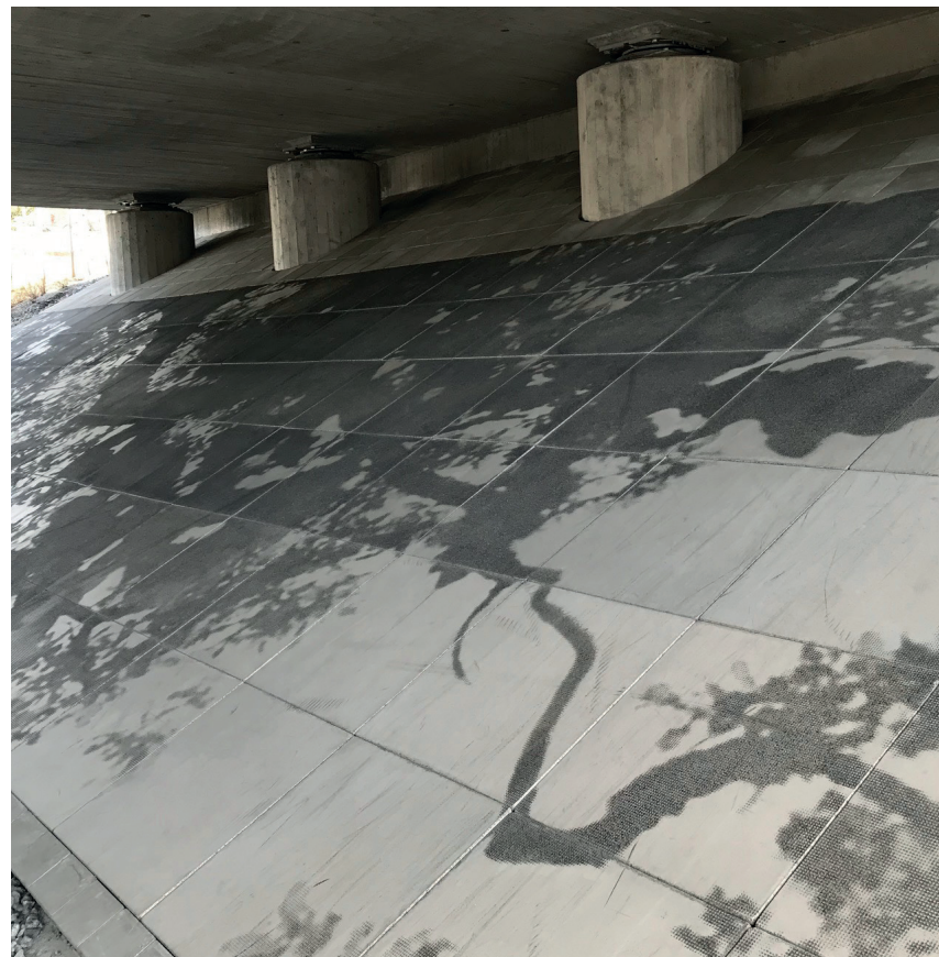
Konstnärlig gestaltning i form av konstverk med lövtak i betongplattorna i gång- och cykeltunnel under Tyresövägen vid Petterboda.
