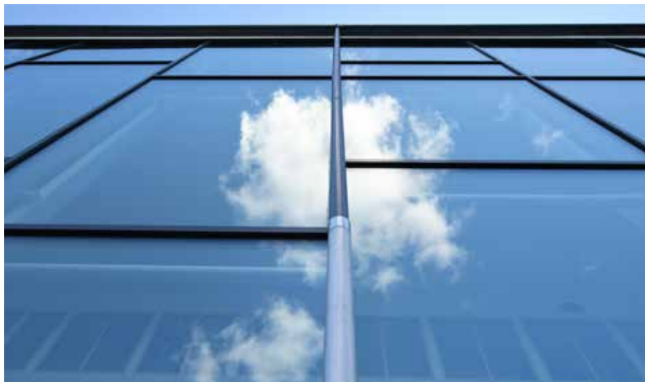
På Nyboda skola har stuprörens placering på ett medvetet sätt anpassats till de stora glaspartiernas indelning. Putsningen av fönstren sker med skylift.
