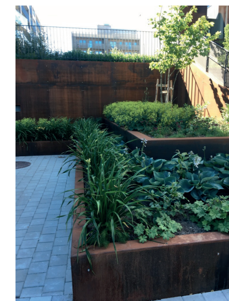
Nivåskillnader på bostadsgårdar tas upp med stödmurar med genomarbetad gestaltning, som utförs antingen i formgjuten betong utan synliga skarvar, alternativt av betongelement som kläs i antingen granit eller trögrostade stål likt bild ovan.
