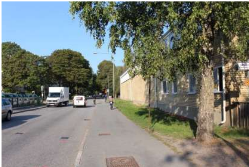
Bild 2) Gångbanan utmed Västertorpsvägens norra sida.
