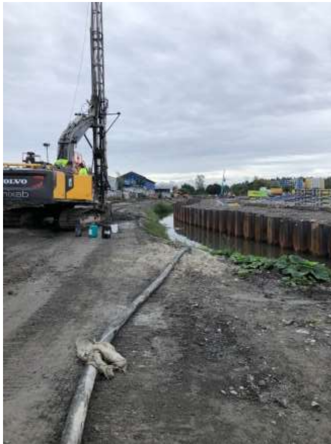
Figur 14 Markarbeten inför byggandet av Bromstensstaden. Foto: Miljöförvaltningen, Stefan Troëng
