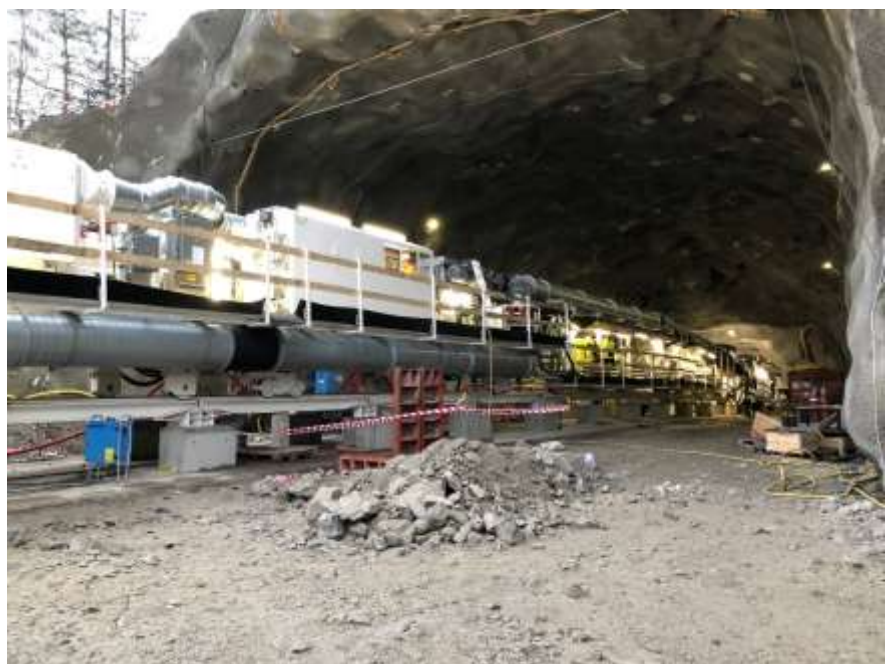
Figur 10 Tunnelbormaskinen vid Anneberg, Danderyd. foto Miljöförvaltningen, Stefan Troëng
