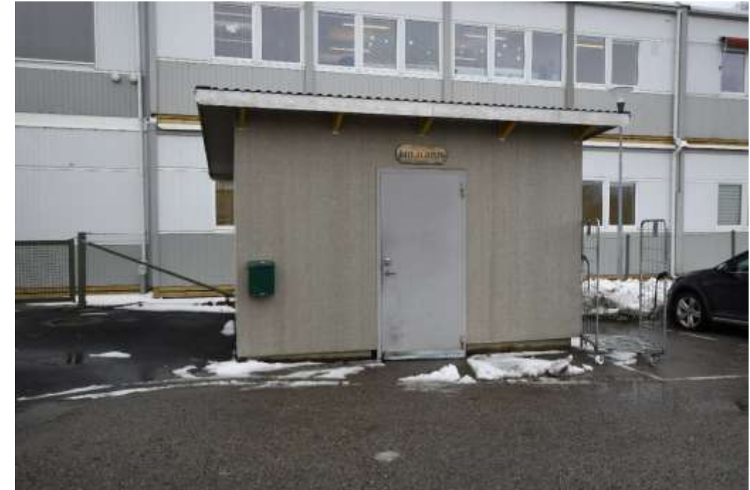
Brandskyddsinklädnad av avfallshuset
