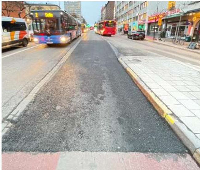
Bild 6. Ny bärkonstruktion och asfaltsbeläggning vid Odengatan 53.
