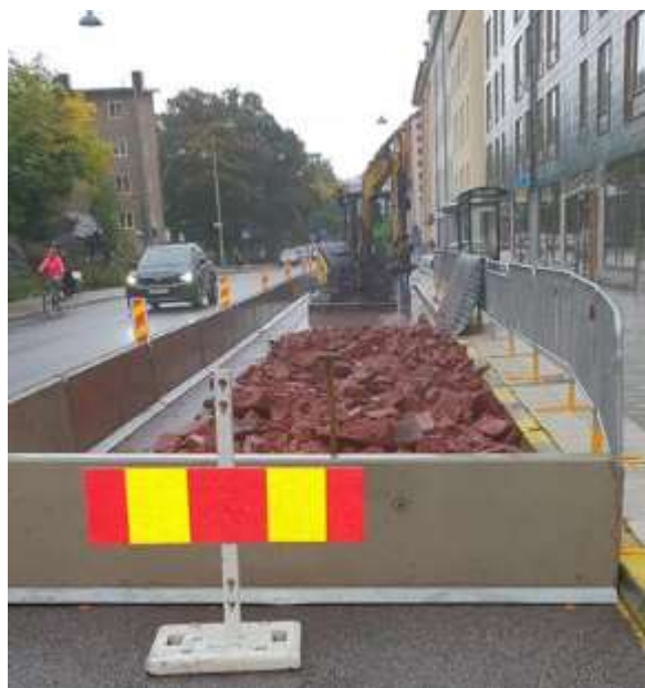
Bild 1. Pågående arbete vid Rosenlundsgatan 32, befintlig platta rivs.
