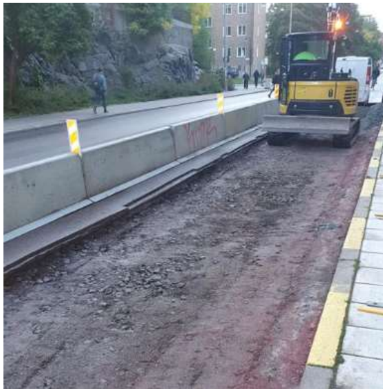
Bild 2. Pågående arbete vid Rosenlundsgatan 32, nytt bärlager.
