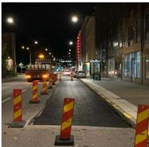
Bild 3. Ny bärkonstruktion och asfaltsbeläggning vid Rosenlundsgatan 32.
