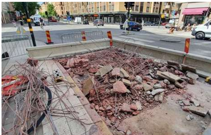
Bild 4. Pågående arbete med borttagning av tidigare konstruktion vid Odengatan 9.
