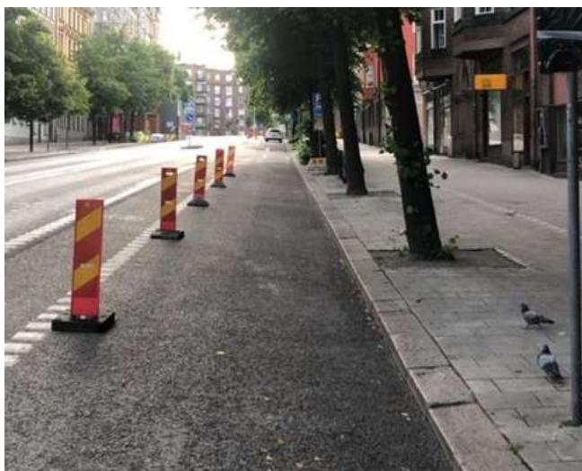
Bild 5. Ny bärkonstruktion och asfaltsbeläggning vid Odengatan 9.
