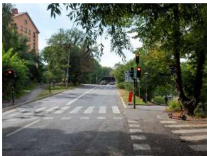
Bild 6 - Vy västerut i höjd med Pålundsbron
