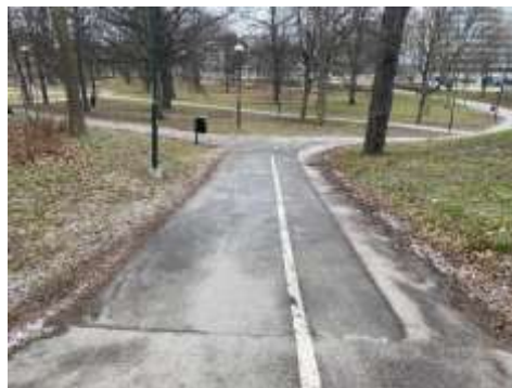
Bild 1. Gjørwellsgatan mot pendlingsstråk Rålambshovsparken, före åtgärd.
